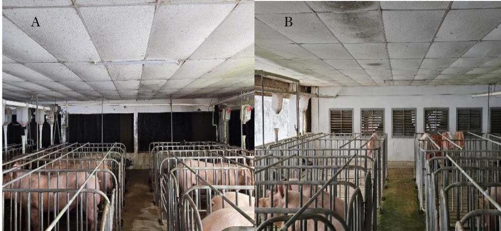
Figura 2. Instalaciones con ambiente controlado mediante el sistema de pared húmeda (A) y ventiladores (B) para la productividad de los cerdos macho (verracos) en el trópico.
